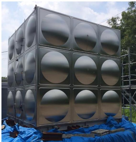
写真-1 ステンレス鋼製パネルタンク
