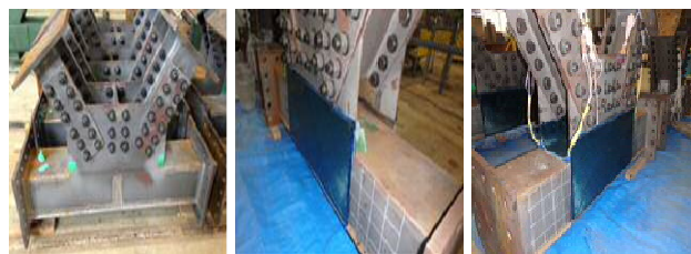
図 3 格点部補修工法
