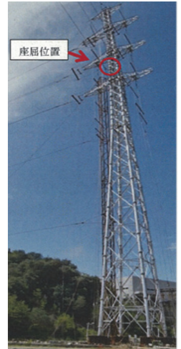
図-1 実規模耐力試験に用いた鉄塔
