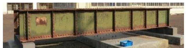
図-1 実験橋梁写真(G1 桁側)
