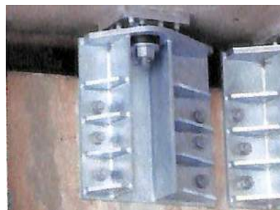
写真-1 ピン型変位制限装置
