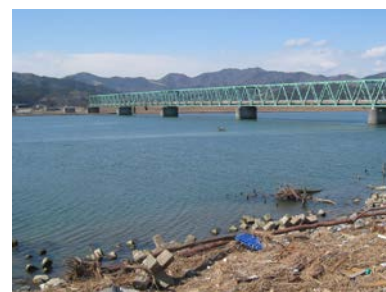
図-6 津波後の新北上大橋と残存する流れた松の木
