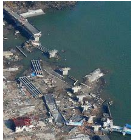
図-8 流失した歌津橋
