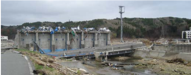
図-9 仰向けの2径間連続コンクリート橋
