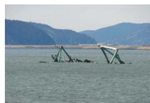
図-3 流されたトラス橋
