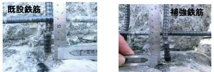
写真-1 軸方向鉄筋の破断状況
