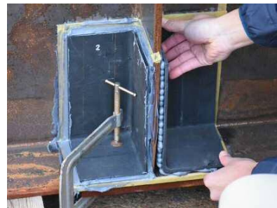
Step 3 CFRP 板接着・固定
