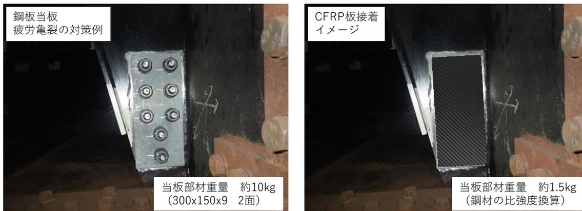
図 1 従来の当板対策と CFRP 板による当板対策のイメージ
