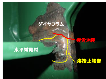
図-4 溶接部近景
