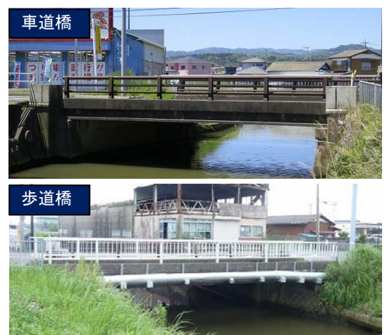
写真-1 対象橋梁
