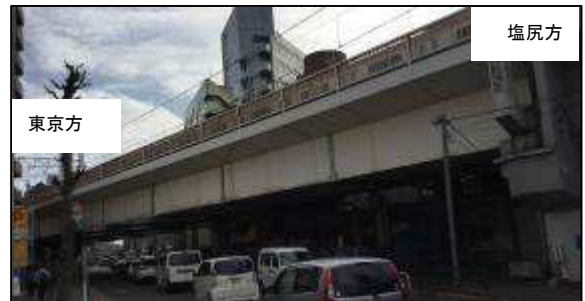
写真-1 橋りょう外観
