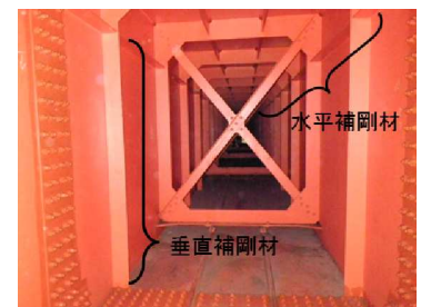
写真-2 橋りょう内観
