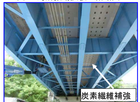
写真 1 対象橋梁(桁下面)
