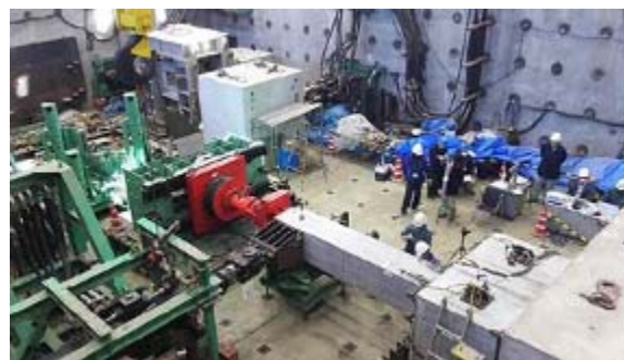
写真-1 実験のセットアップ状況
