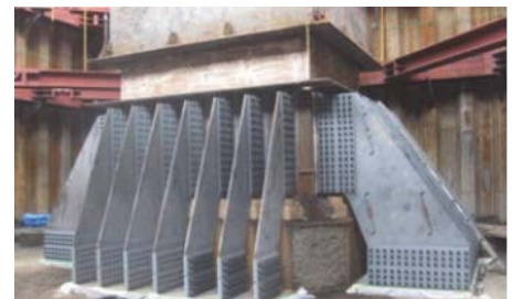
写真-1 基部拡張補強構造の設置状況
