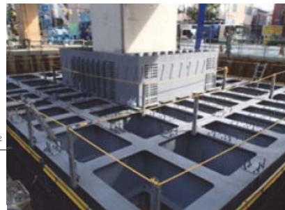
写真-2 鋼製格子部材の設置状況
