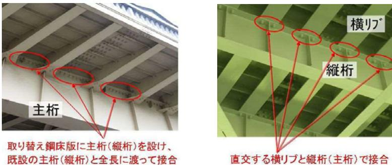
取り替え鋼床版に主桁(縦桁)を設け、既設の主桁(縦桁)と全長に渡って接合
