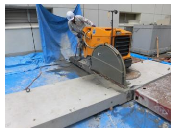
写真-3 床版切断状況
