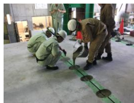
写真-1 コッター床版の現場作業
