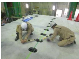
写真-1 コッター床版の現場作業
