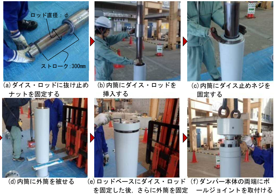
写真-2 大容量摩擦ダンパーの組立て状況
