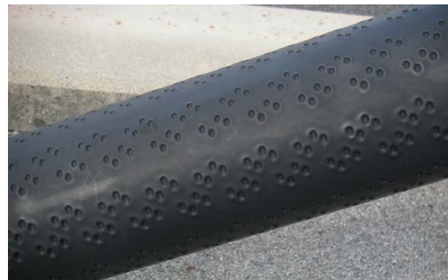
図1 インデントケーブル(多々羅大橋)
