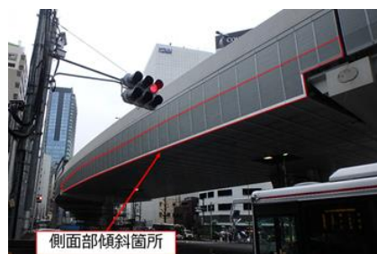
写真-1 恒久足場の外観
