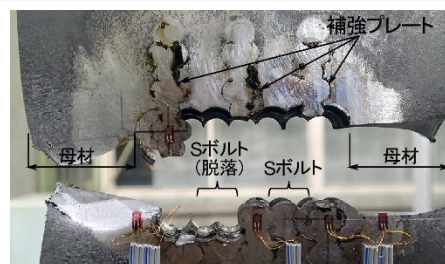
図-5 疲労試験後の状況 (S ボルトあり)
