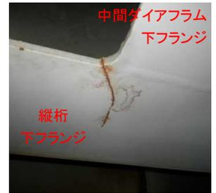
図4 継手⑤におけるき裂
