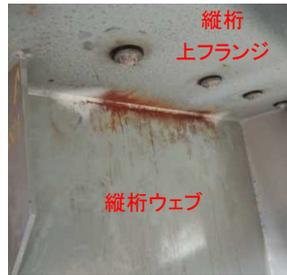
図3 継手②におけるき裂
