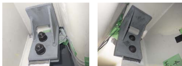
図7 試験施工写真
