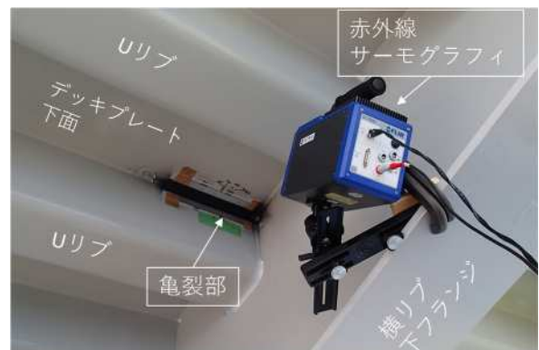
写真-1 赤外線サーモグラフィによる計測状況
