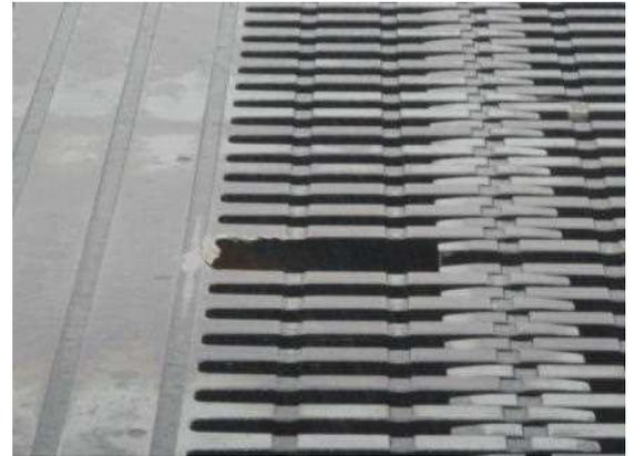
図-1 フィンガー疲労損傷状況
