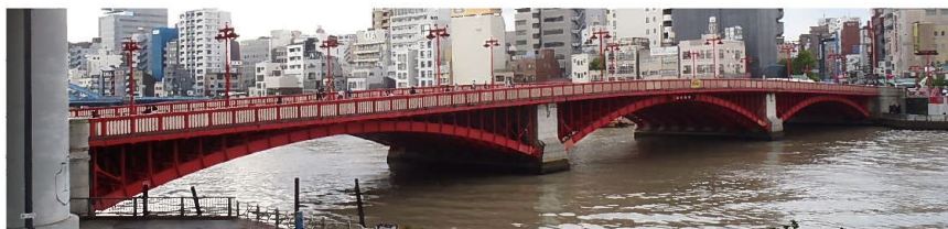
写真－1 橋梁全景
