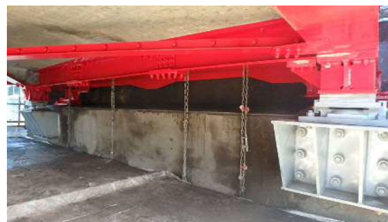
写真-3 桁端部補修完了
