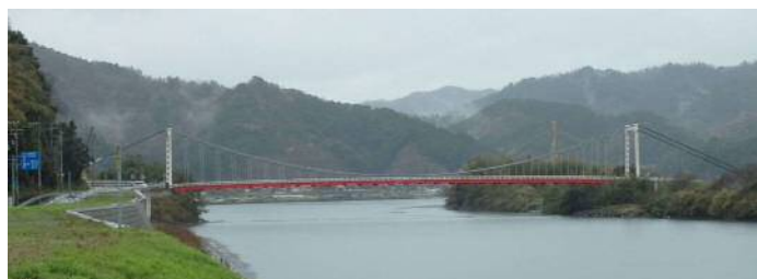
写真-1 橋梁全景
