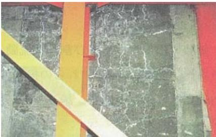
写真 - 1 床版コンクリート（下面）の劣化状況
