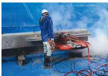
(a) 主桁上コンクリートの水平切断
