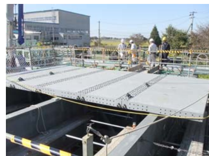
(b) 床版部材の架設
