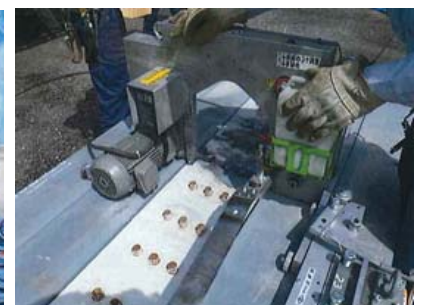
(b) 主桁上スタッドの切断
