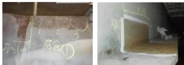
写真-1 塩分測定の調査箇所の一例
