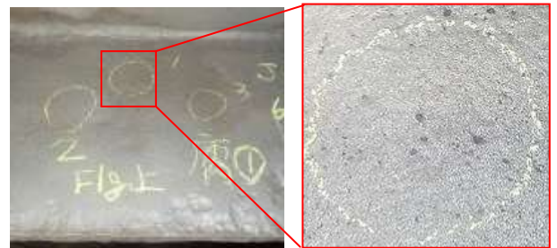
写真-2 腐食部の素地調整後の鋼材表面の状態
