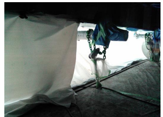
図1 足場養生の状況
