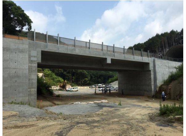
写真-1 原種架道橋
