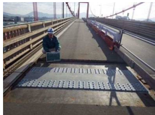
写真-3 新連結板による鋼床版連続化
