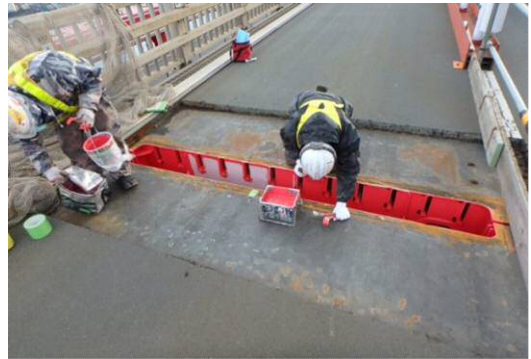
写真-2 既設鋼床版ブロック端部間の塗り替え塗装
