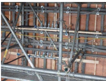
写真-1 エアクーリング用ホース配置
