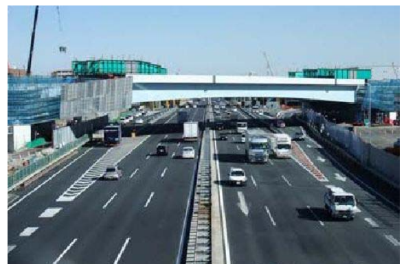
写真-2 架設完了
