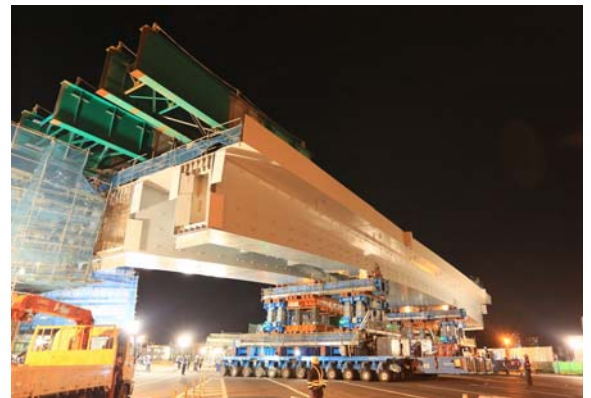
写真-1 一括架設状況
