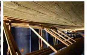
写真5 鋼桁と床版の接合
