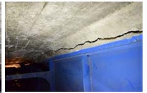
写真3 鋼桁と床版の分離
