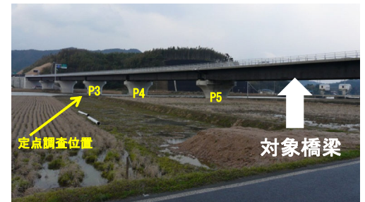
図 4 対象橋梁の全景写真
