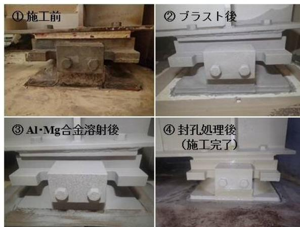
図-3 亜鉛めっき支承へのAl-Mg合金溶射施工
