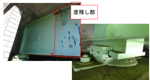
写真-1 塗替え後の桁端部(土浦橋)
