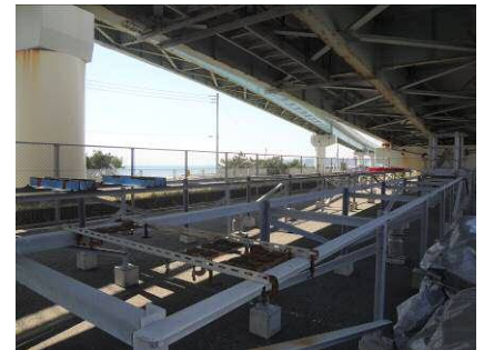
図-2 暴露試験場の状況
