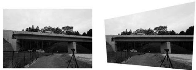
(a) 射影変換前の撮影画像 (b) 射影変換後の画像
