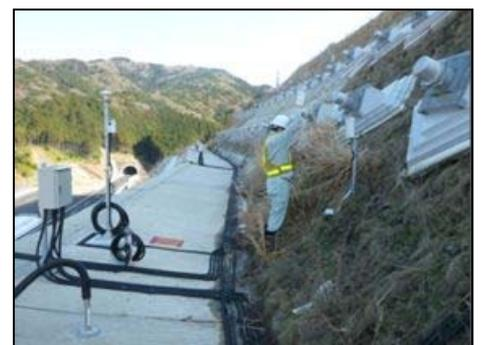
図-2 従来方法のアンカー荷重計
