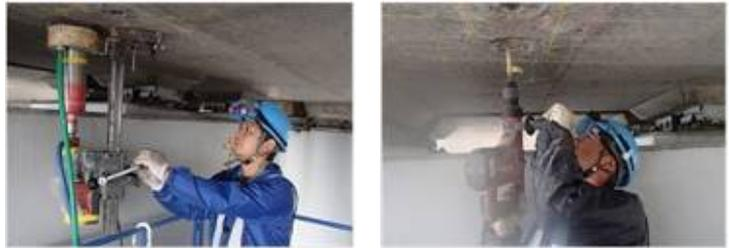
写真-2 削孔およびはつり作業状況
