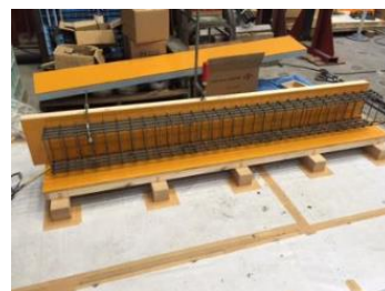
写真-1 試験体の製作状況
