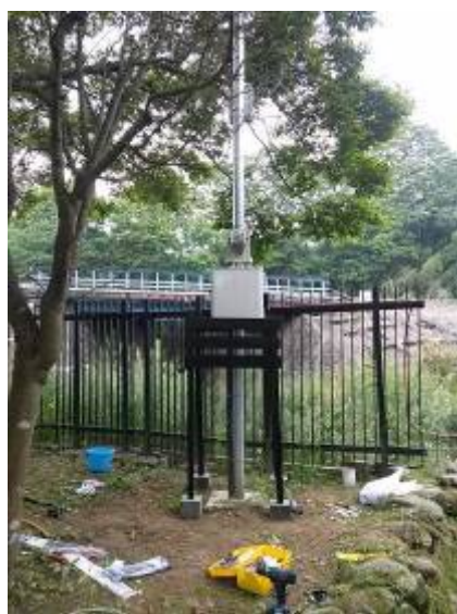
図-4 内水氾濫監視システム (沢渡川通信ボックス・配電盤)
