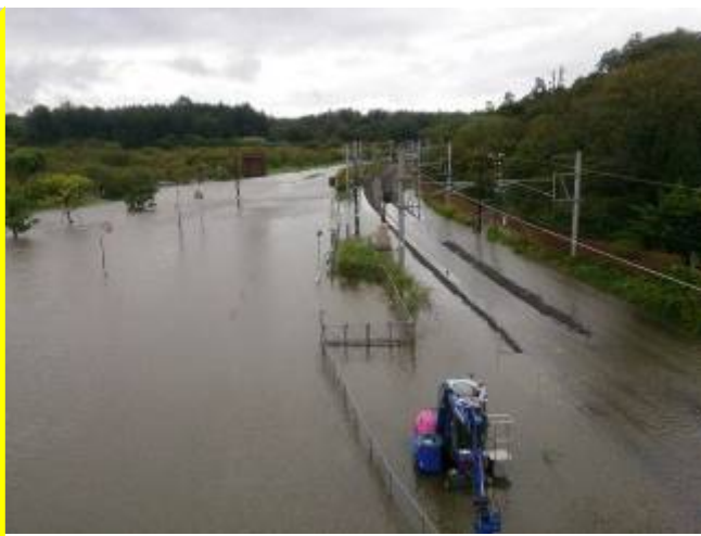
図-2 2014 年 10 月 6 日の冠水被害状況 (茨城県水戸土木事務所 HP)
