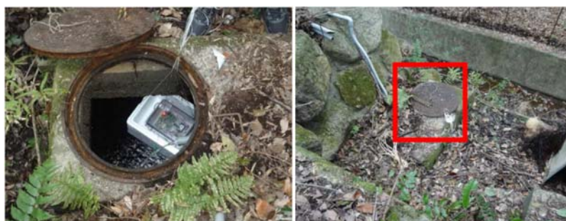
図-3 マンホール埋設前後の様子
