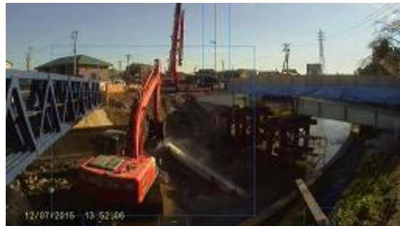
図2 背景差分法による物体検出 （重機には青色の矩形表示をして分別表示）
