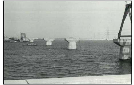
図-4 提供を受けた写真 (桁架設中の東西線荒川・中川橋梁)
