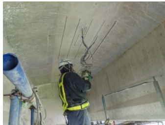
写真 2 試験箇所の床版状況
