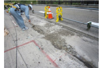
写-1 RC床版上面 目視確認状況
