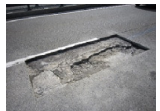
写-2 試掘部床版上面 写真
